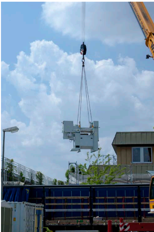
Abb. 3-7: Einbringung der neuen Tiefdruckmaschine
