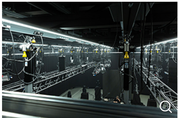
Die Studiodecken wurden komplett erneuert (Foto: Florian Müller)
